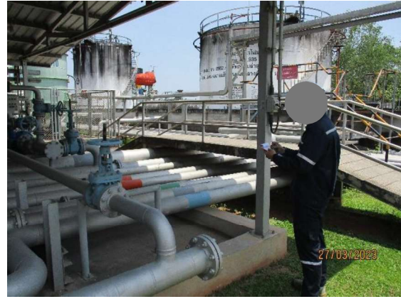
ภาพถ่ายที่ 2.2-15 การตรวจสอบบริเวณท่อส่งน้ำมันด้วย สายตา
